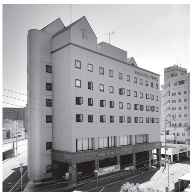
本館のすぐ隣にある 「アネックス」外観
