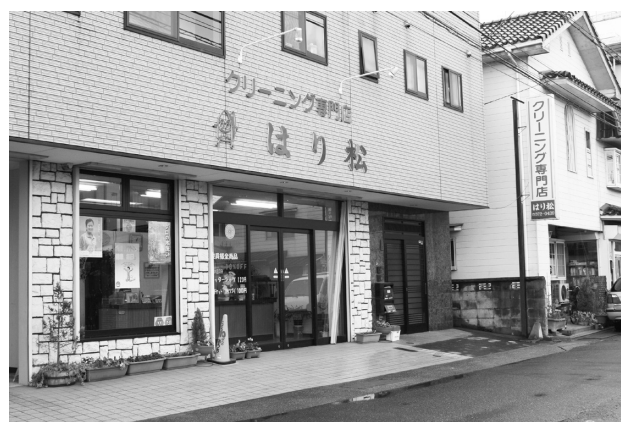
道路から店舗へと段差をなくしバリアフリー化した店舗。組合員の多くがバリアフリー化に取り組んでいる
