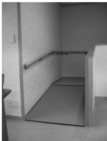
洋間から浴室に向かってスロープと手すりが設けられている（ホテルニュー松実）
