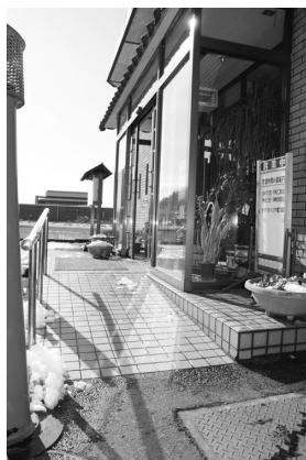
店舗玄関に新設されたスロープ（鯖江市の「御園飯店」で）
