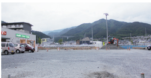
大船渡夢横丁テナント工事中(2018.5.23撮影)
