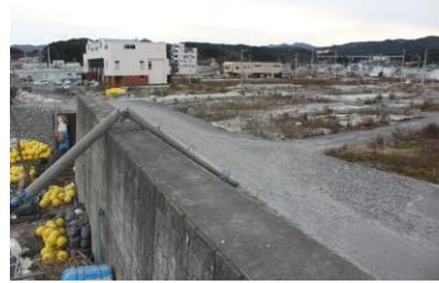
被災した建物は礫は撤去されたが原野のまま 破壊された防潮堤。地盤沈下で海水が岸壁まで侵入
