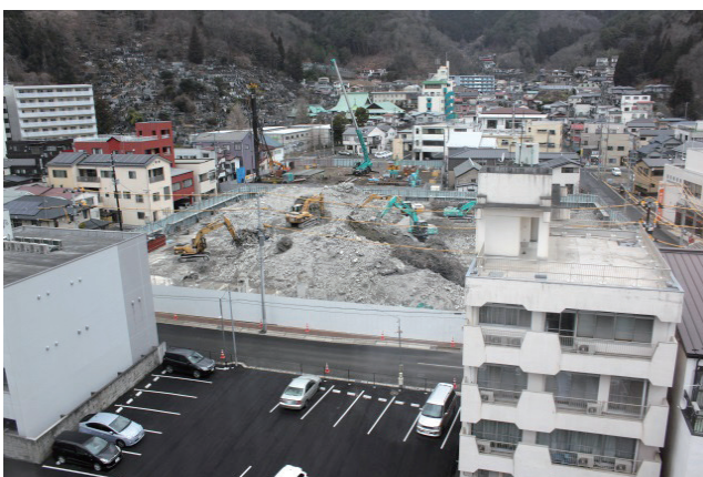
釜石市 中心街の状況（2015.1.7 撮影）
