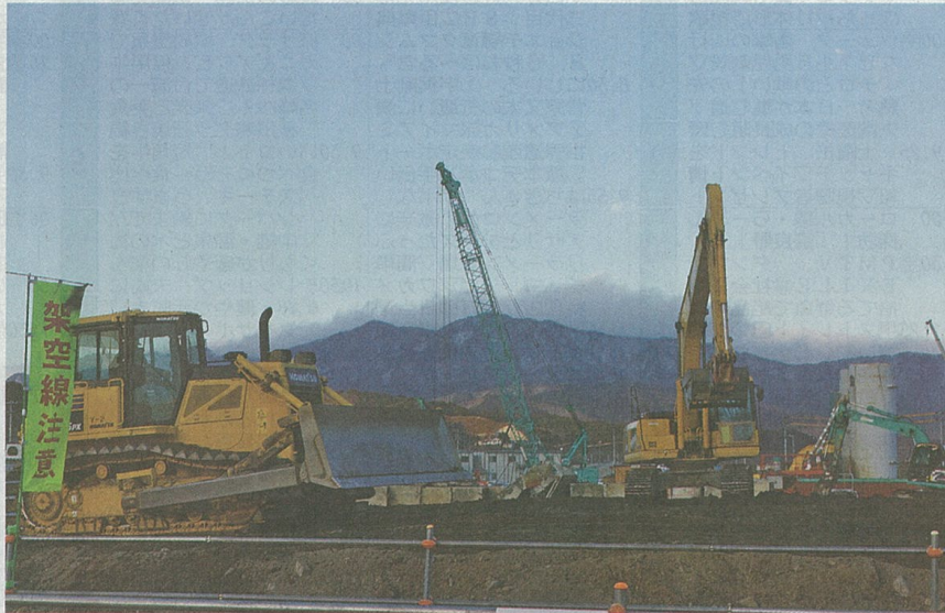
「まちなか再生区域」となる山田町中心部。商業施設などの建設に向け、土地整備が進む=6日
