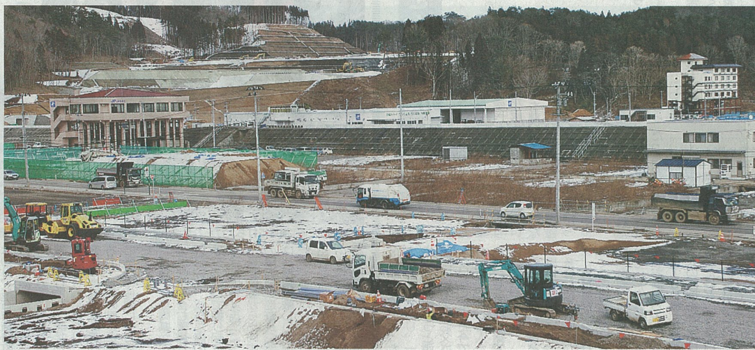
住宅再建に向けて平地と高台の造成が進む田老地区。国道沿いのルート変更工事も行われている。宮古市田老
