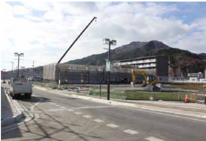
「おおふなと夢商店街」の工事状況 (2017.1.18 撮影)
