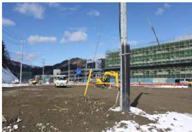
国道 45 号付近の工事状況 (2017.1.18 撮影)
