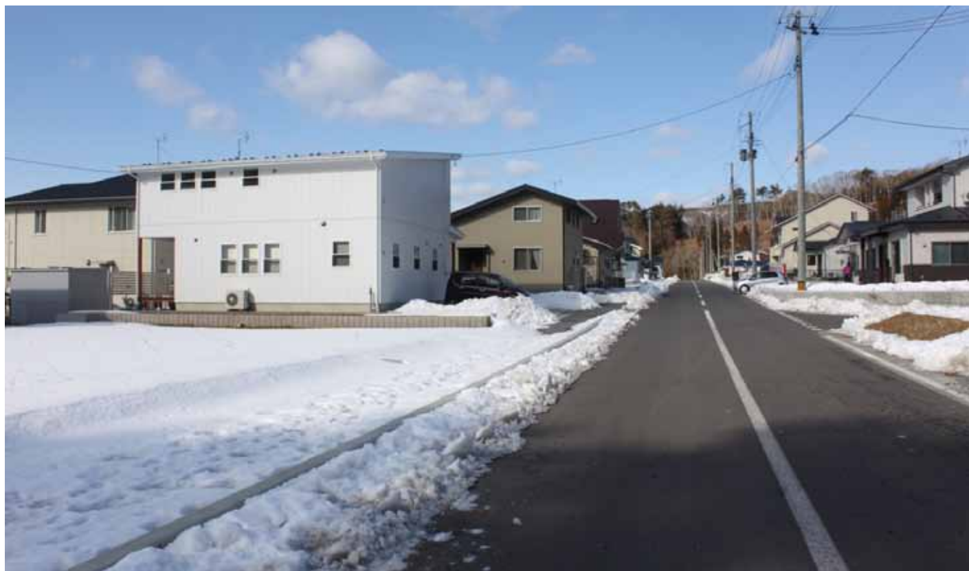
高台移転先での住宅建設（2017.1.31 撮影）
