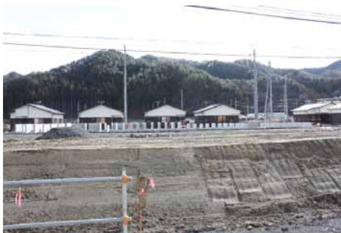
国道 45 号付近に「住宅」建設 (2017.2.24 撮影)
