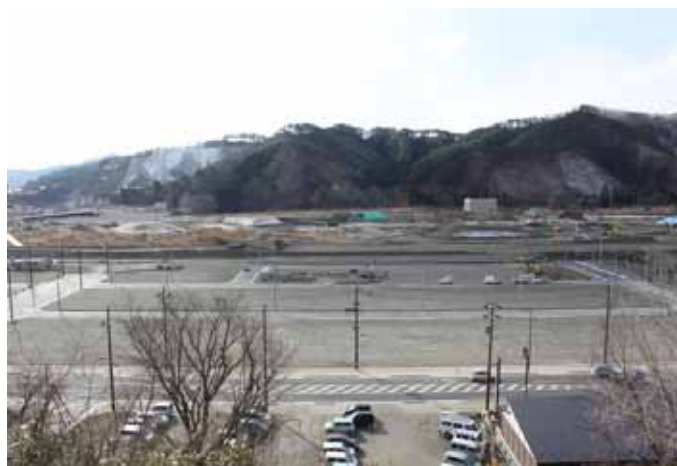
現役場前周辺嵩上げ工事 (2017.2.24 撮影)
