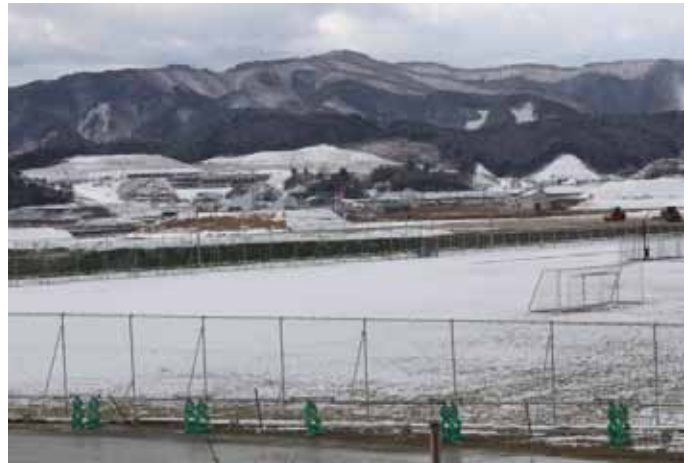
進む嵩上げ工事 (2017.2.24 撮影)
