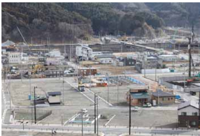
住宅建設が進む旧役場周辺 (2017.2.24 撮影)
