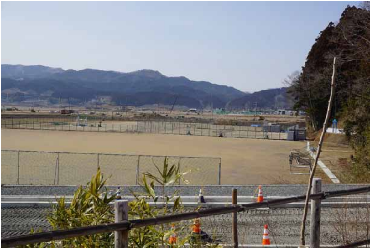
キャピタルホテル1000から「アバッセ高田」方面の工事状況（2018.3.3撮影）
