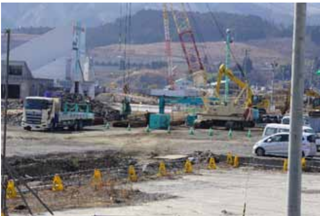
旧道の駅周辺の工事状況（2018.3.3撮影）
