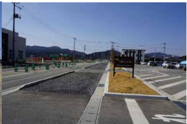
「アバッセ高田」前の工事状況（2018.3.3撮影）
