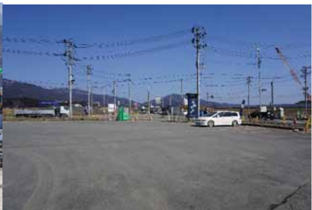
一本松茶屋周辺の工事状況（2018.3.3撮影）
