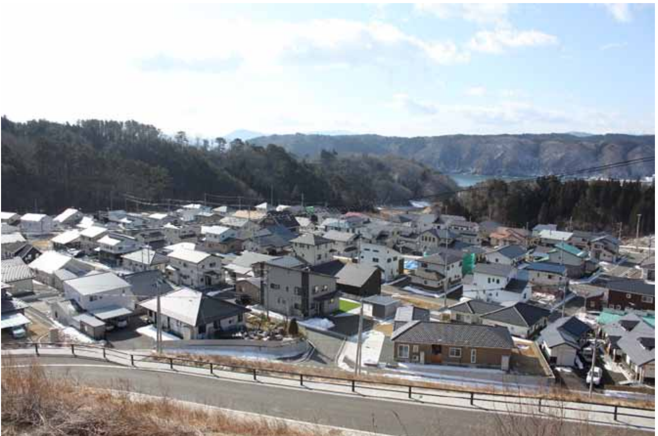
高台移転先での住宅建設状況（2018.2.20 撮影）
