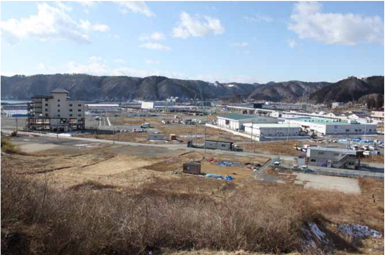
店舗建設が進む市街地（2018.2.20 撮影）
