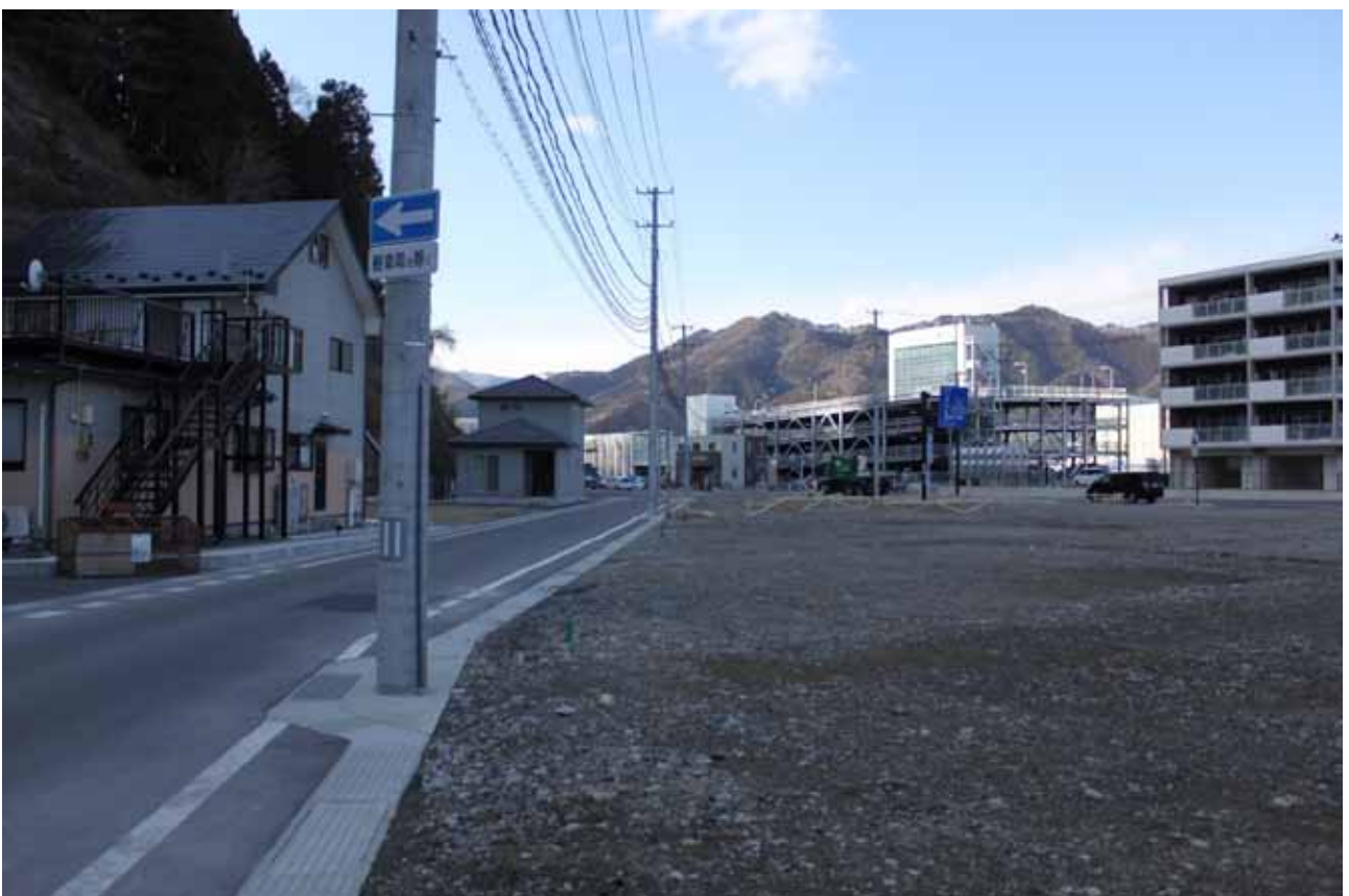
国道 45 号付近の工事状況 (2018.2.20 撮影)
