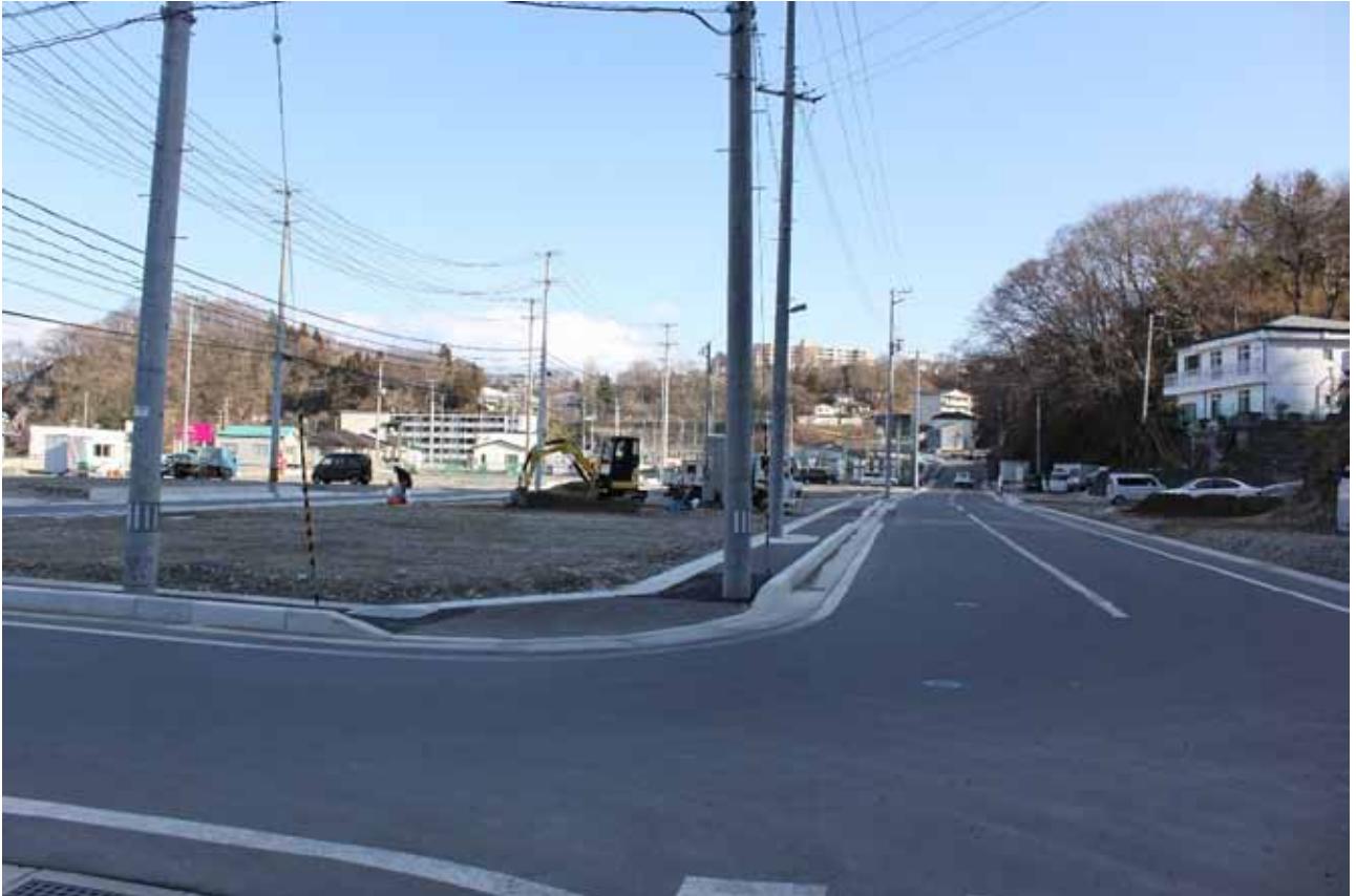
国道 45 号付近の工事状況 (2018.2.20 撮影)
