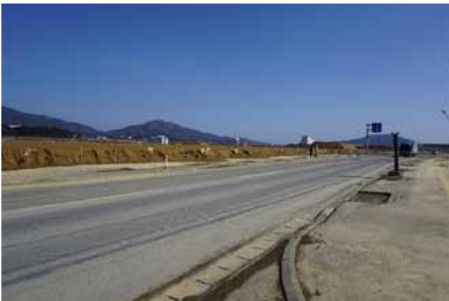
遠く旧道の駅を望む地点の工事状況（2018.3.3撮影）
