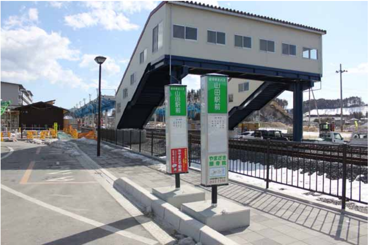
山田駅が建設中（2018.2.20 撮影）
