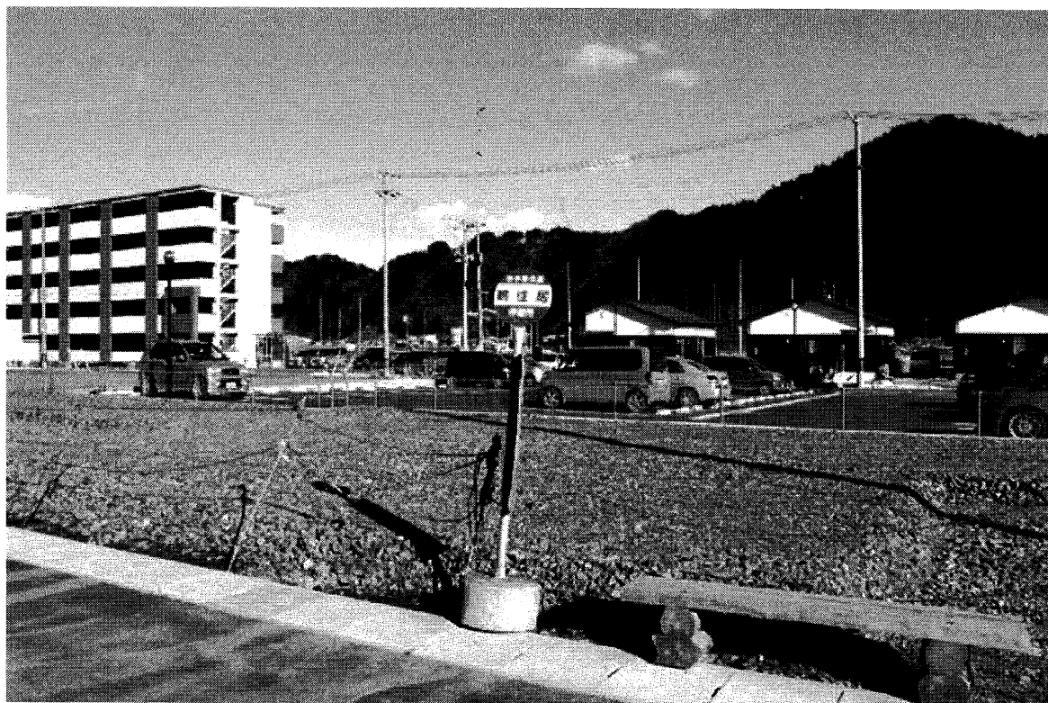
国道 45 号付近に「災害公営住宅」建設（2018.2.20 撮影）
