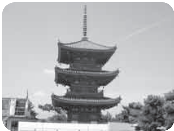
室町初期の建造とされる遍照院・三重塔
