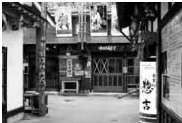
広場の奥にある「戦後焼け跡バラック長屋」と名付けられた建物
