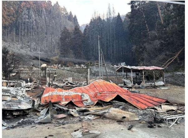
火災の被害を受けた家屋
